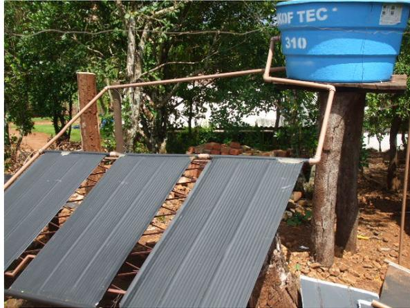
**Figura 1** Coletor solar de baixo custo construído
